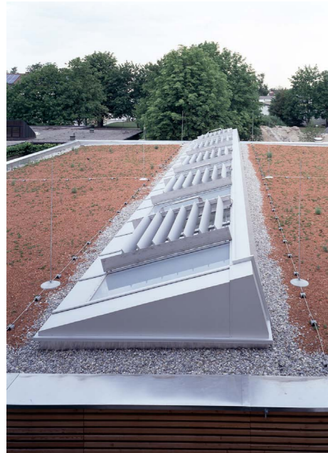
Beispiel für die integrierte Planung: Die Belichtungsstudie des Passivhaus Instituts Darmstadt hat direkten Einfluss auf die Gestaltung der Sporthalle und die konstruktive Ausbildung der Oberlichter. Sie führt somit zu Energieeinsparung und einer Senkung der Betriebskosten. Quelle: PSA Architekten, München
