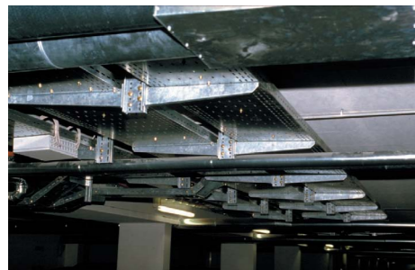
Abhängen einer Decke
