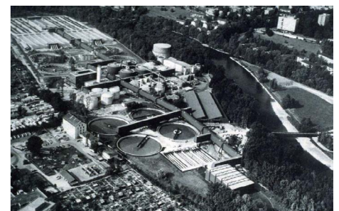
Luftbild einer kommunalen Kläranlage
