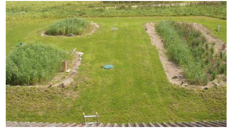
Pflanzenbeetkläranlage für 20 Einwohnergleichwerte Quelle: http://www.landmeyer.org/pflanzklaeranlage/index.html
